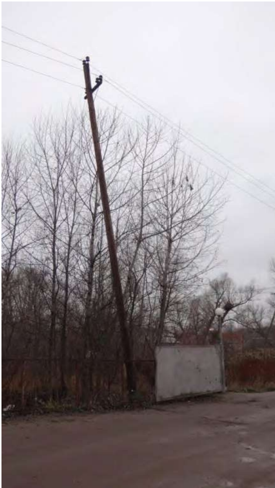
Фото №2 – наклон опоры ВЛ
