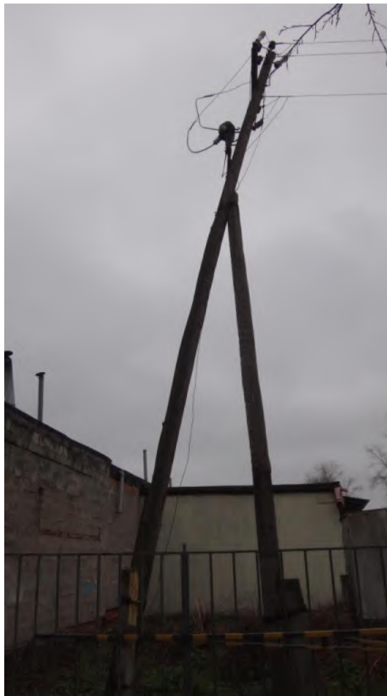
Фото №5 – Сближение проводов, повреждение изоляторов
