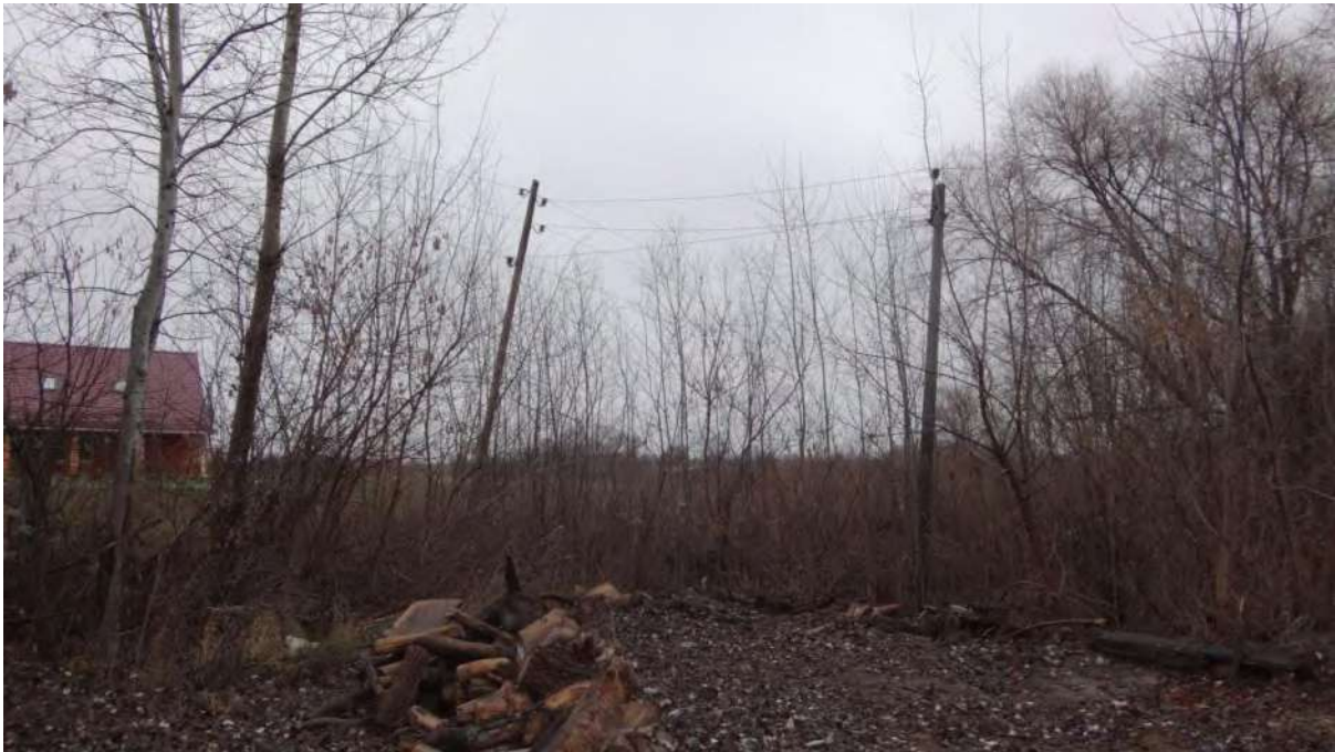
Фото №1 – наклон опоры ВЛ
